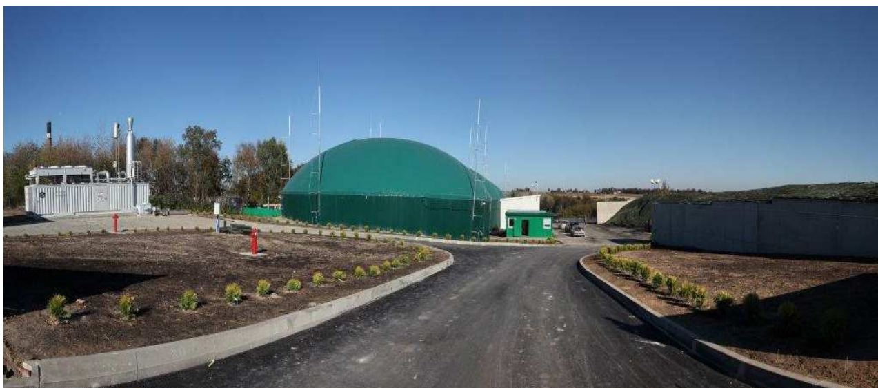
Brama wjazdowa (źródło: wikanabioenergia.pl)
